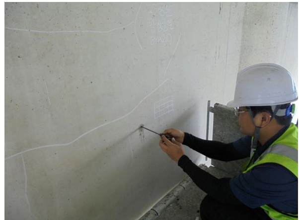
탄산화 깊이 측정
